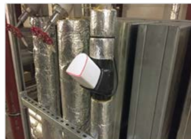
Hycleen Automation System assure une gestion fiable de l'eau potable avec des températures constantes supérieures à 55 °C et un équilibre hydraulique.
