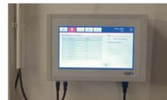
La technologie sanitaire intégrée est facile à utiliser à partir du Master. Le panneau est connecté à des contrôleurs qui pilotent avec précision les vannes et les capteurs individuels.
