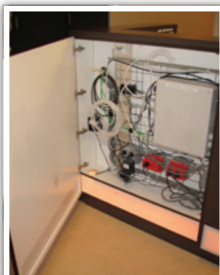
Les desks de radiologie sont très techniques tout en restant esthétiques : l'arrière s'ouvre sur les câblages électriques, les écrans sont sur rail et une armoire dissimule le rack de commande.
