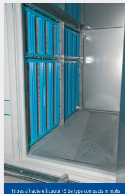
Filtres à haute efficacité F9 de type compacts miniplugs
