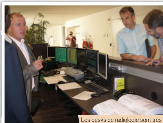
Les desks de radiologie sont très techniques tout en restant esthétiques : l'arrière s'ouvre sur les câblages électriques, les écrans sont sur rail et une armoire dissimule le rack de commande.
