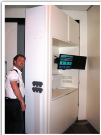
Les desks de radiologie sont très techniques tout en restant esthétiques : l'arrière s'ouvre sur les câblages électriques, les écrans sont sur rail et une armoire dissimule le rack de commande.
